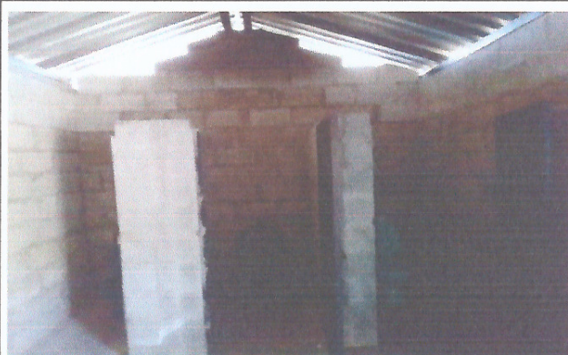
Foto 4: Mejoramiento de servicios sanitarios.
