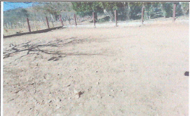
Foto 2: Mejoramiento de losa de patio.
