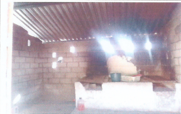
Foto 3: Reparación de área de cocina.
